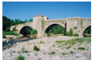
Spigno: Die mittelalterliche Brücke
